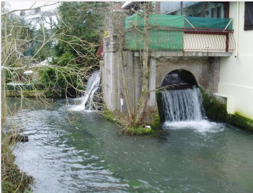
Figure 16 : Seuil de décharge du moulin de Rosay (OFB)
