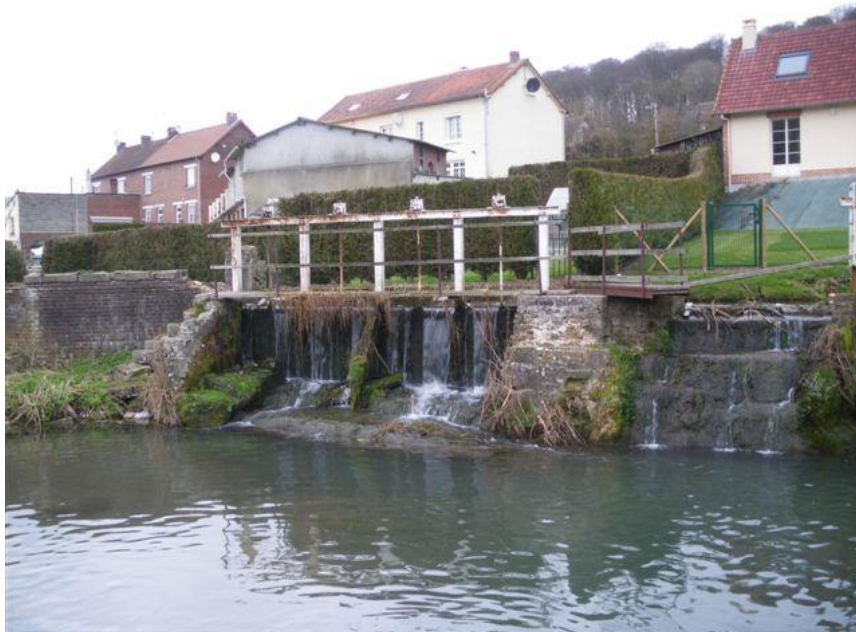
Figure 15 : Seuil de décharge de la pisciculture la Fonte (OFB)
